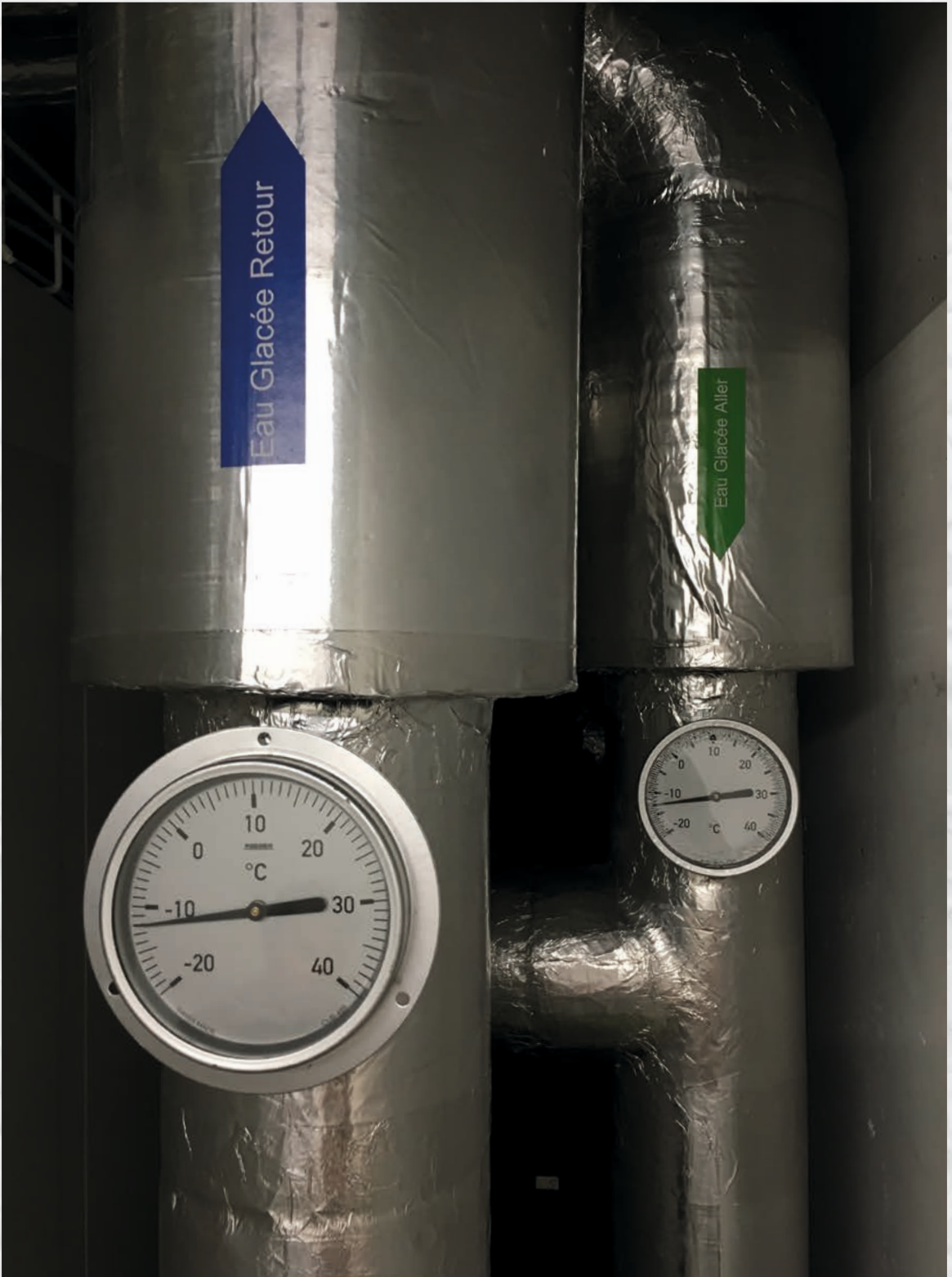
Agroscope Nyon – Systèmes de refroidissement isolés avec swissporKISODUR PIR Alu
