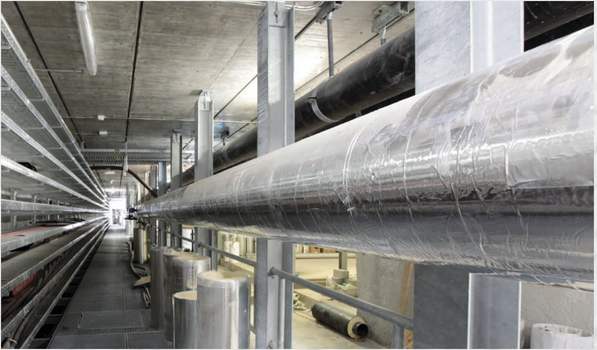
Aéroport International de Genève – Conduite incendie (eau froide) DN 250 mm; Longueur conduite env. 400 mètres
