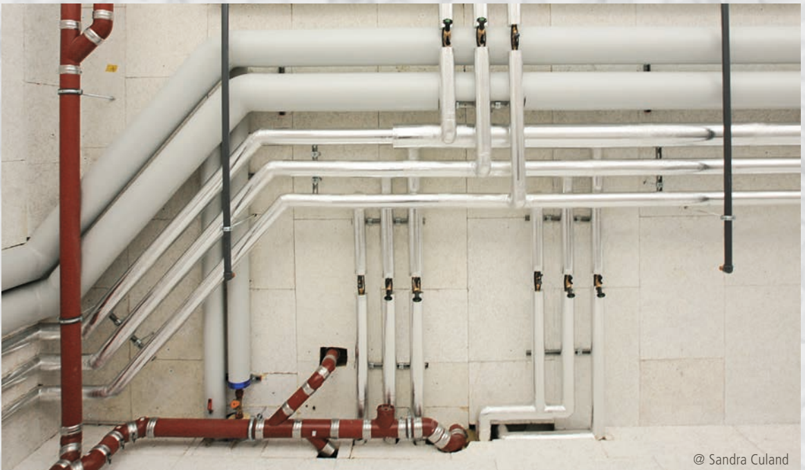
Immeuble locatif en PPE à Nyon – Installations sanitaires eau chaude-froide isolées avec swissporKISODUR PIR Alu renforcé
